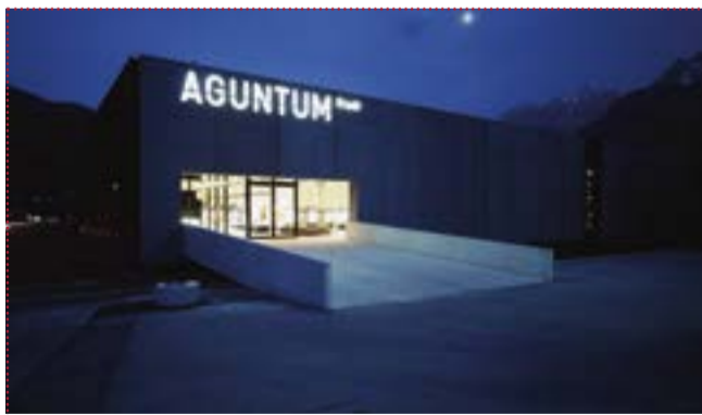
Der moderne Museumsbau von Aguntum liegt in der Gemeinde Dölsach bei Lienz.
